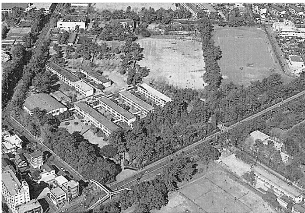
時習館高等学校 航空写真 グラウンドの広さが際立っている
