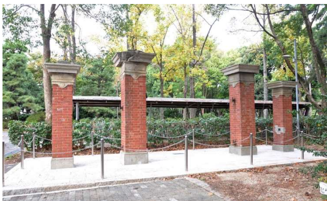
豊中正門の保護工事
