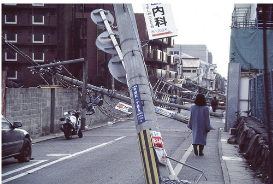
電柱が倒れ道を塞いでいた
