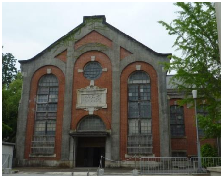
蹴上発電所の正面
